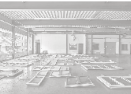
Beim Umbau eines Lebensmittel-Verteilungszentrums 2021 in Basel zum ELYS Kultur- und Gewerbehaus entstand eine neue große Fassadenfläche. Das Baubüro in situ fragte dafür im Umkreis von rund 100 Kilometern Fensterproduzenten nach „Lagerfenstern“ an. So konnten 200 neuwertige Fenster eingebaut werden, die aufgrund von Überproduktion oder Fehlbestellungen bei den Firmen lagerten und sonst aus Platzgründen entsorgt worden wären.
