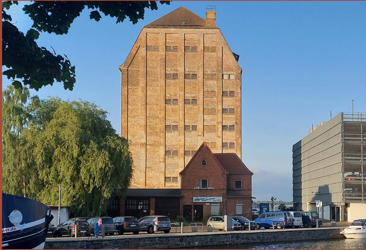
Silo III / Putzspeicher, 1912
