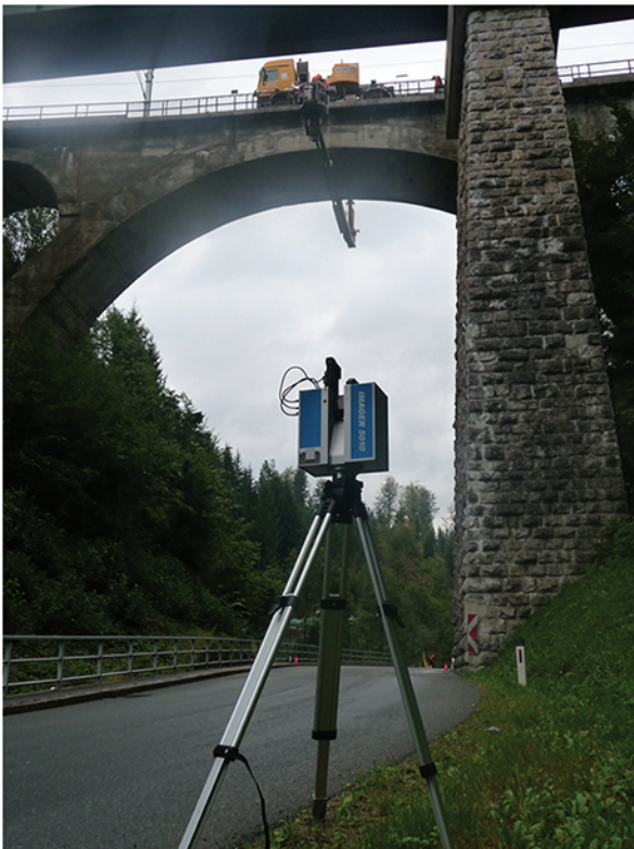
3D-Laserscanning zur Deformationsüberwachung der Mosbach-Brücke in Fieberbrunn, Österreich, Foto: Gebhardt
