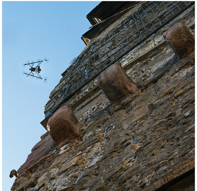
Luftbildaufnahmen mit Unbemanntem Fluggerät (UAV) am Schiefen Turm von Bad Frankenhausen, Foto: Späth
