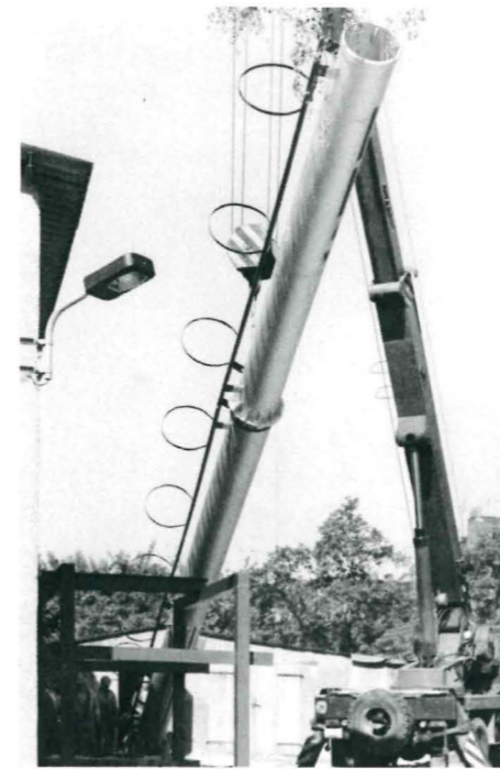
Abb. 16: Montage der Versuchsanlage zur Kohlenstaubverbrennung in der Coudraystraße, 1980. Forschungsvorhaben an der Sektion Baustoffverfahrenstechnik unter Leitung von Reinhard Schmidt, Lehrstuhl Wärmetechnik. AdM der BU Weimar.
