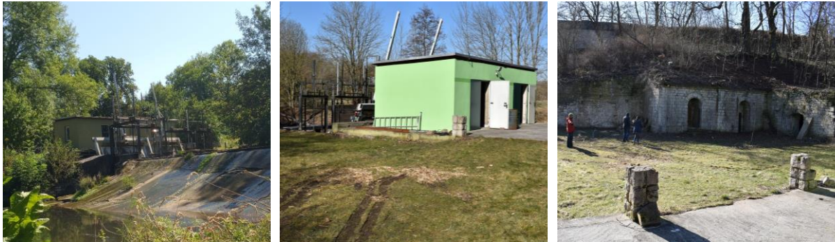
Abbildung 1-3: Wehr (links), Turbinenhaus (Mitte), Grundstück mit Kellergebäuden (rechts) an der Kleinwasserkraftanlage Oberroßla
