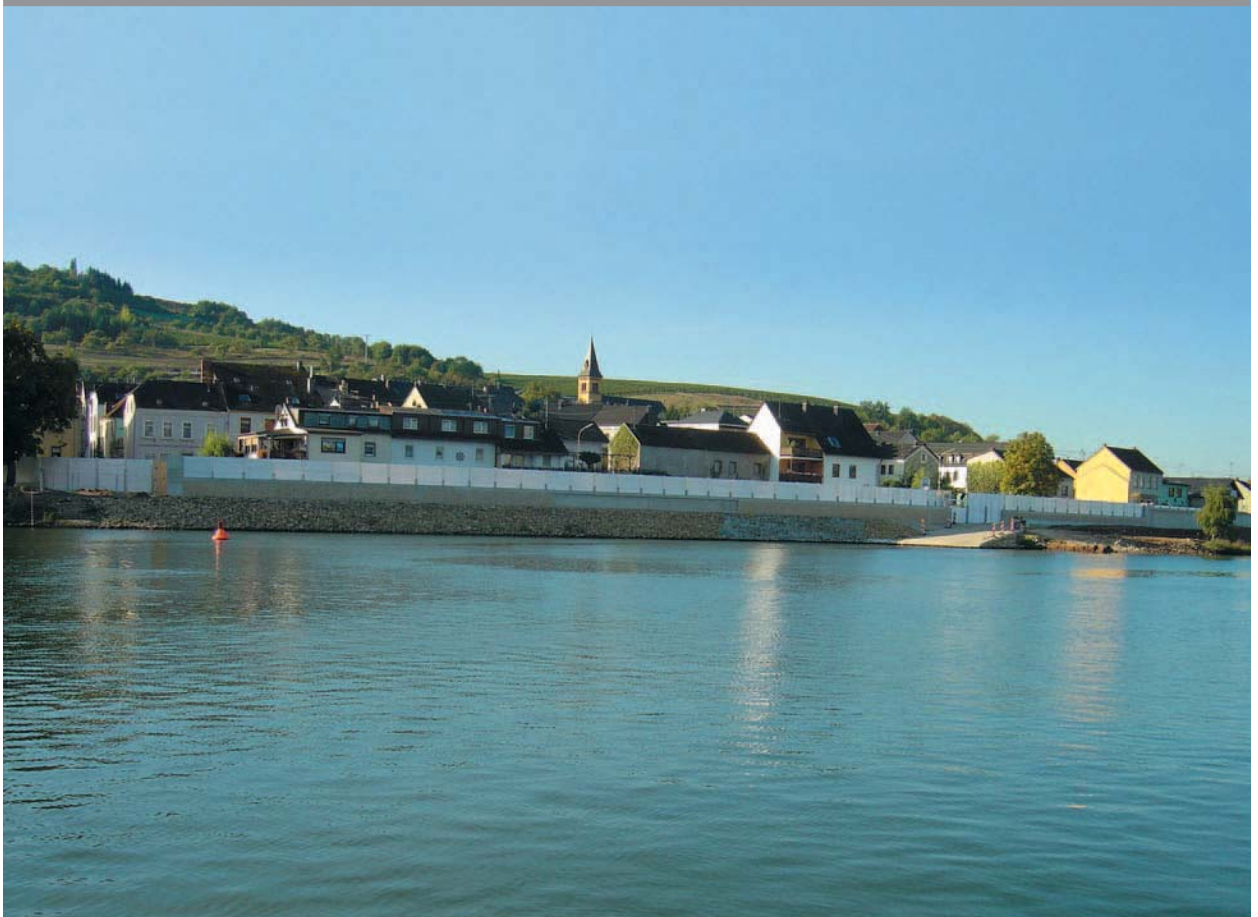
Hochwasserschutz in Oberbillig an der Mosel
