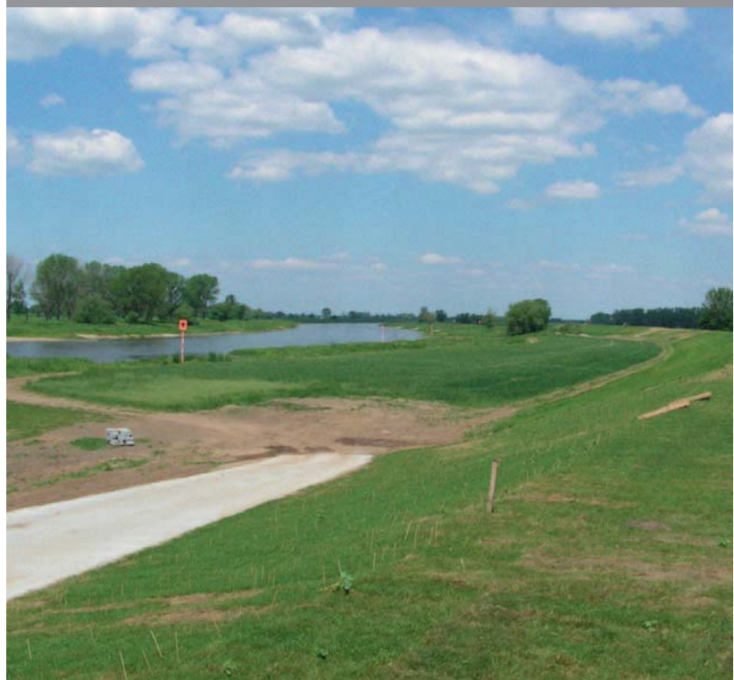
Wiederhergestellter Hochwasserschutzdeich an der Elbe
