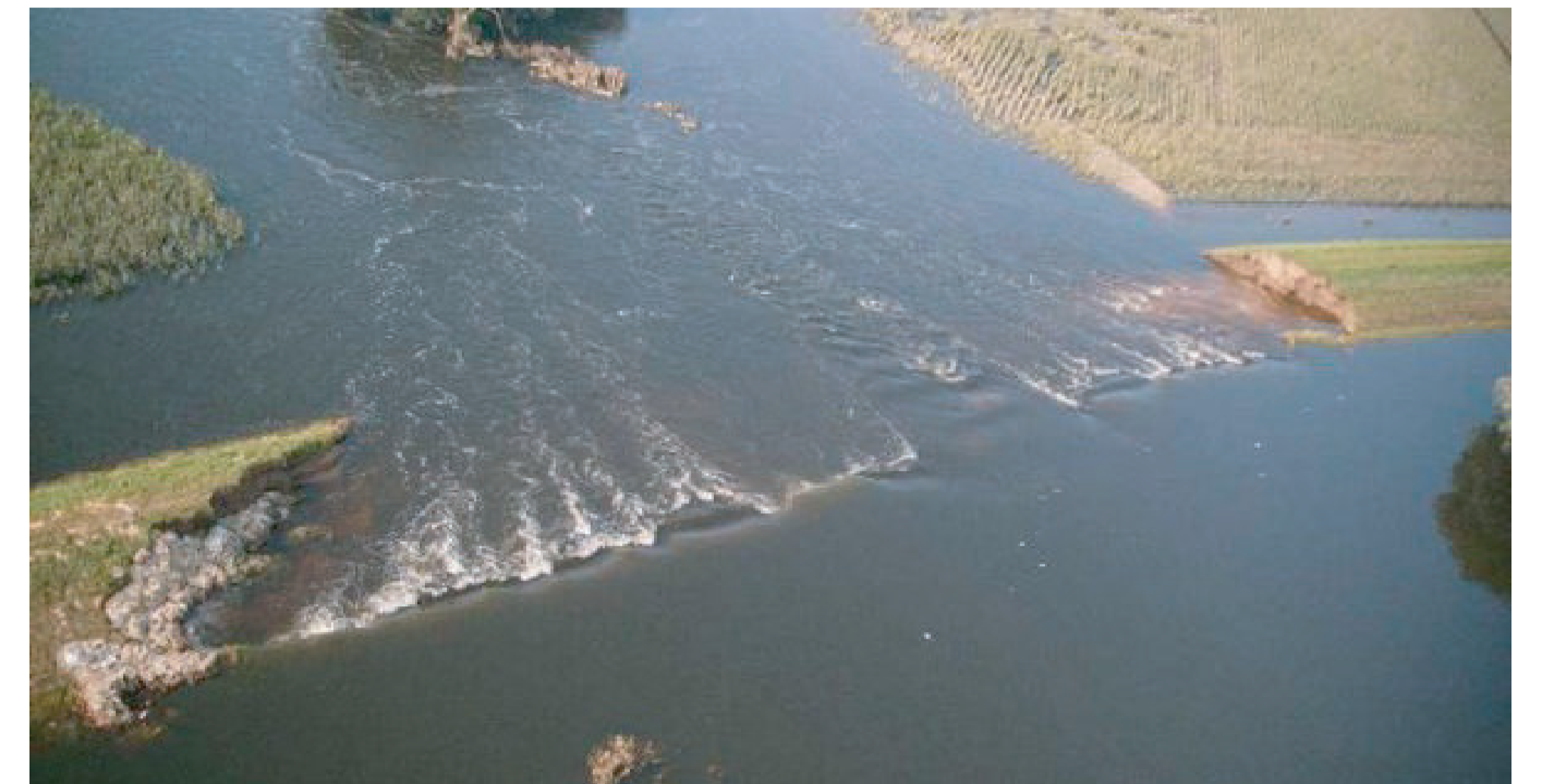
Bild 2: Deichbruch bei Seegrehna (Landkreis Wittenberg) während des Hochwassers 2002 an der Elbe
