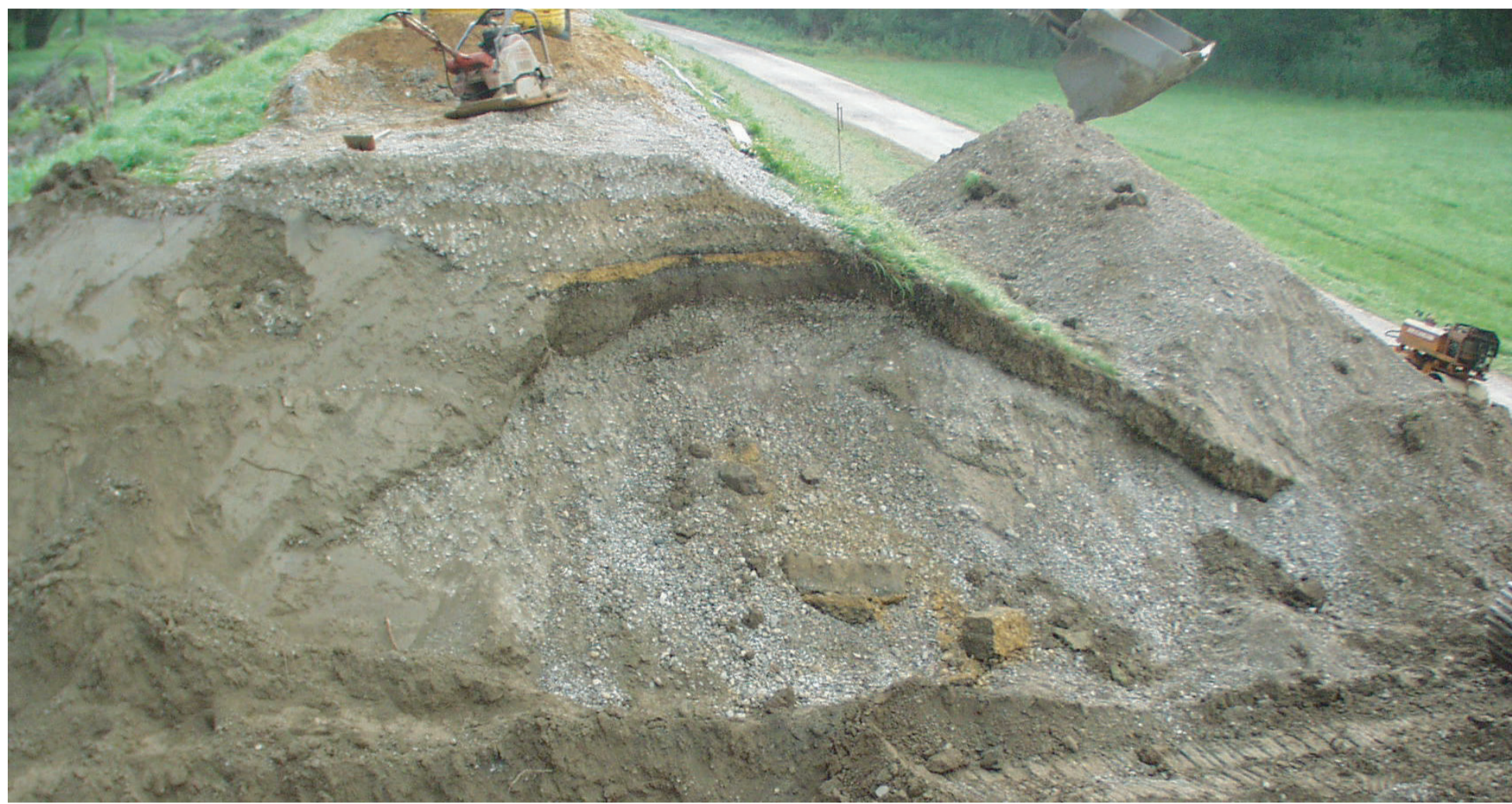
Bild 1: Historisch gewachsener Deich mit willkürlichem, u.U. heterogenem Aufbau
